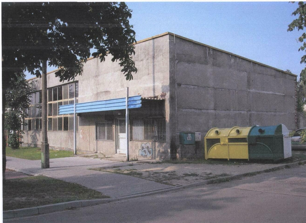
Fot. 1 Elewacja południowo – zachodnia budynku, Ekspertyza stanu technicznego budynku wymiennikowni ciepła w Brzeszczach, BAUREN Renke Piotr, 2007.
