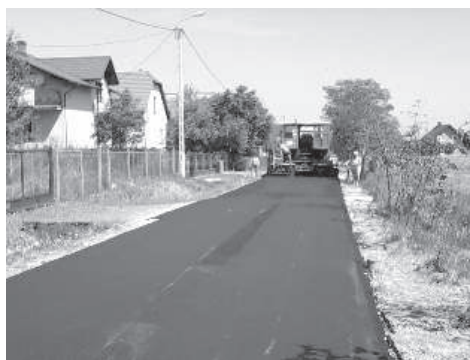
Remont ul. Kolonia w Wilczkowicach
