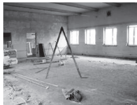
Prace remontowe w remizie brzeszczańskich strażaków potrwać do grudnia
