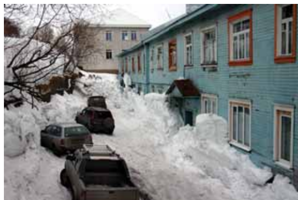
Dom, w którym mieszkał Łukasz Wawro. Kwiecień. Na dworze słonecznie, wokół ogromne zasy śniegu. Temperatura około -10 °C.
