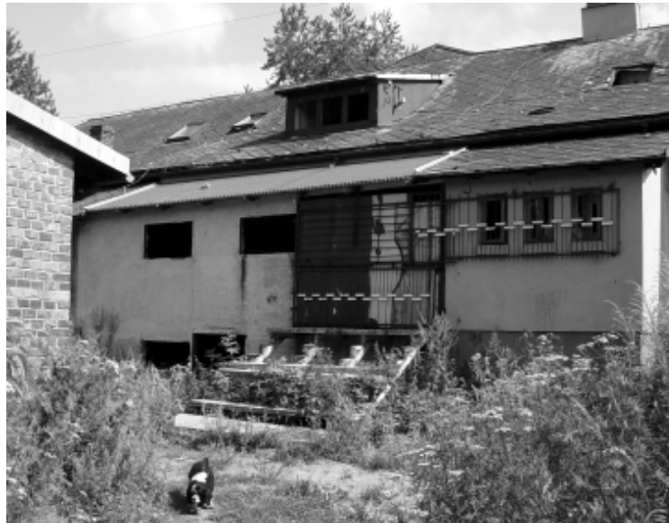
Budynek po przedszkolu na Nowej Kolonii jest kompletnie zdewastowany.
