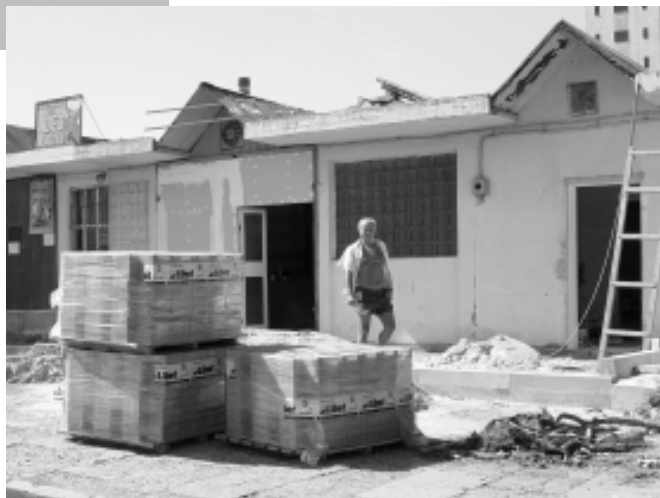
W ostatni tydzień sierpnia prace adaptacyjne prowadzono całą parą.
