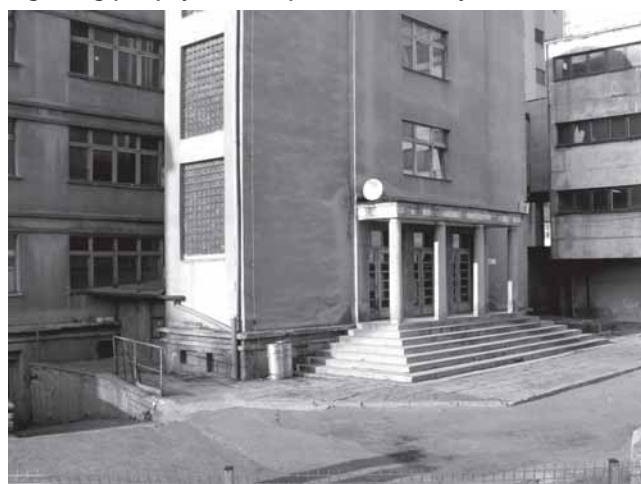
Prace remontowe, które podobno już się rozpoczęły, mają poprawić warunki na kopalnianej łaźni.
