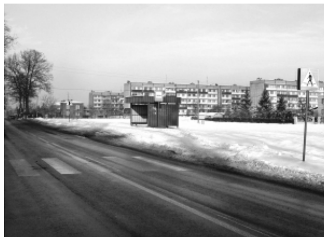
Przejście dla pieszych, na którym samochód potrącił kobietę jest oznakowane.
