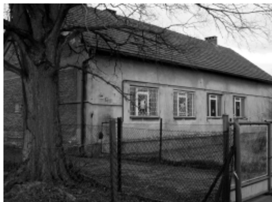
W budynku starej szkoły w Zasolu powstaną mieszkania komunalne.
