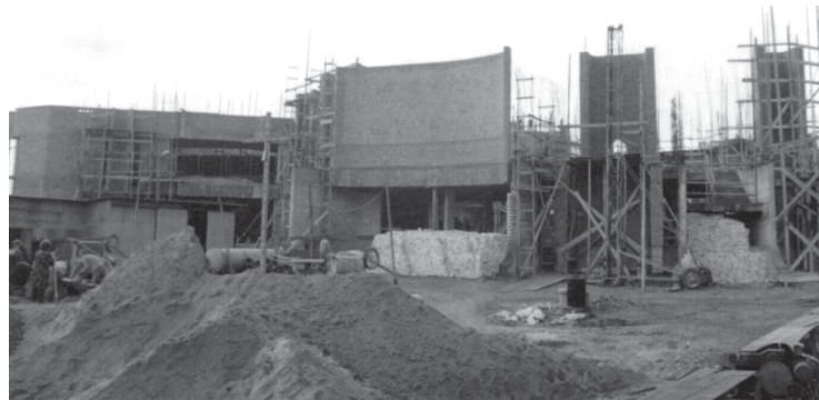
Budowa kościoła Matki Bożej Bolesnej w Jawiszowicach-Osiedlu.
