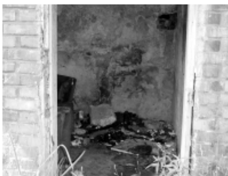
Właściciel budynku po dawnym przedszkolu na Nowej Kolonii obiecał przeprowadzić remont. Czeeka go bardzo dużo pracy.
