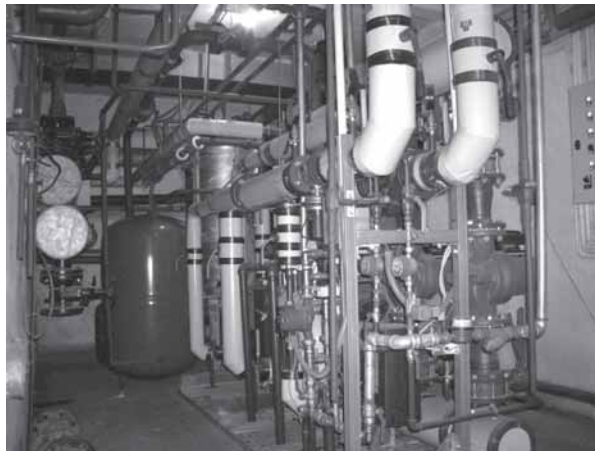
Węzeł kompaktowy w budynku Gimnazjum nr 1.
