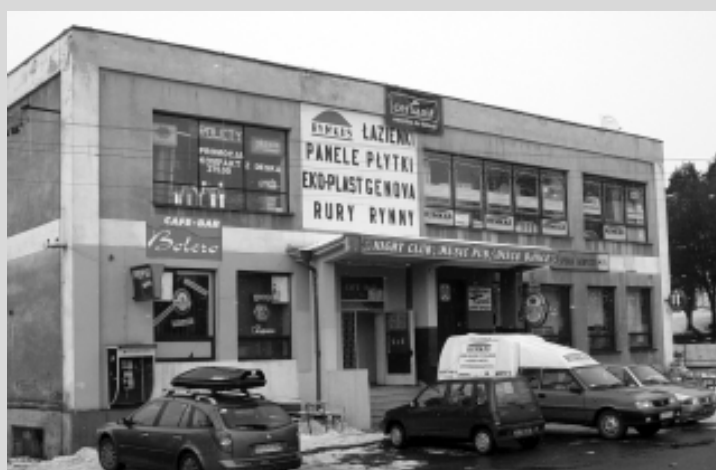
Od 1946 r. w tym samym miejscu stoi budynek, który Krakowskie Towarzystwo Rolnicze 2 czerwca 1950 r. sprzedało GS „Samopomoc Chłopska” w Brzeszczach. Budynek rozbudowano w 1963 r., a dziesięć lat później dobudowano piętro.
