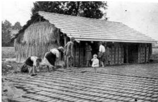
Cegłę dosuszano pod szopą.
