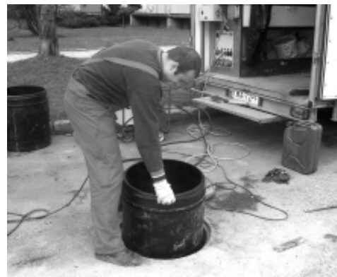
Rury z tworzywa sztucznego włożono w stare odcinki kanalizacji.
