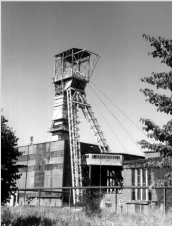
15 listopada 1995 r. zaprzestano wydobycie węgla szybem Andrzej III na Ruchu II KWK „Brzeszcze” w Jawiszowicach. Szyb stoi do dziś.
