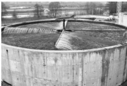
Brzeszczańska oczyszczalnia wymaga inwestycji.
