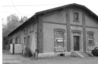
Nawet jeśli gmina przejmie budynki, najpierw czeka je gruntowny remont.
