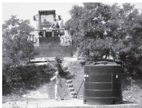
Tankowanie paliwa do kompaktora Bomag z nowej stacji paliw.
