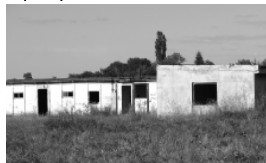
Podobnych budynków przeznaczonych do rozbiórki, jak ten na os. Paderewskiego, jest jeszcze w gminie 17.
