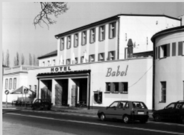
Obecnie właścicielem budynku - Domu Pracownika „Rotunda” jest Nadwiślańska Spółka Mieszkaniowa w Tychach. W budynku mieści się hotel i restauracja „Babel”.
