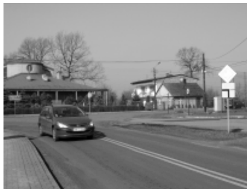
Przebudowa skrzyżowania w Skidzinu to najważniejsza inwestycja w gminie realizowana przez Zarząd Dróg Powiatowych
