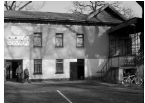
Wymieniono dach na budynku LKS Jawiszowice.
