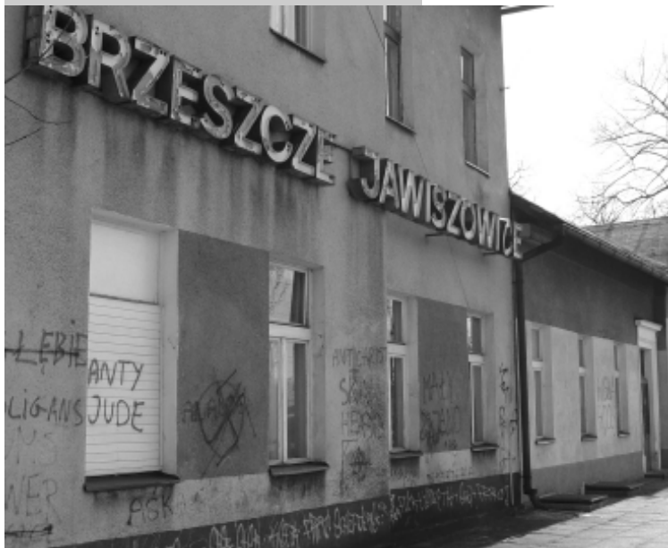
Czy nasz dworzec w tym roku doczeka się remontu?
