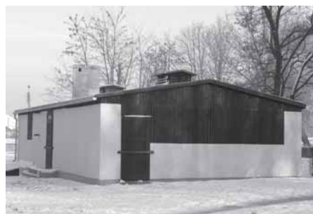
Remont budynku łaźni obozowej zakończył się 26 listopada.
