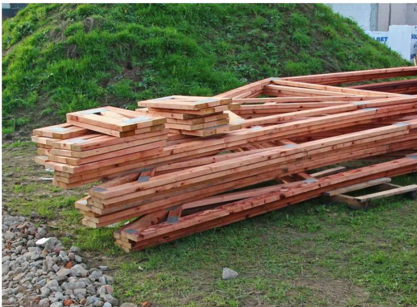
Fot. 5.2 Niepoprawne składowanie wiązarów prefabrykowanych – zarówno z punktu widzenia odległości od podłoża, jak i braku odpowiednio rozmieszczonych podpór, co skutkuje niekontrolowanymi deformacjami wiązarów. (fot. E. I. Kotwica)
