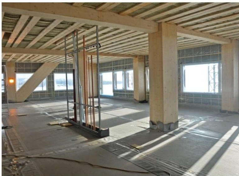
Fot.1. 13. 18-kondygnacyjny budynek Mjøstårnet w Brumunddal na etapie montażu (fot. T. Birgersson)
