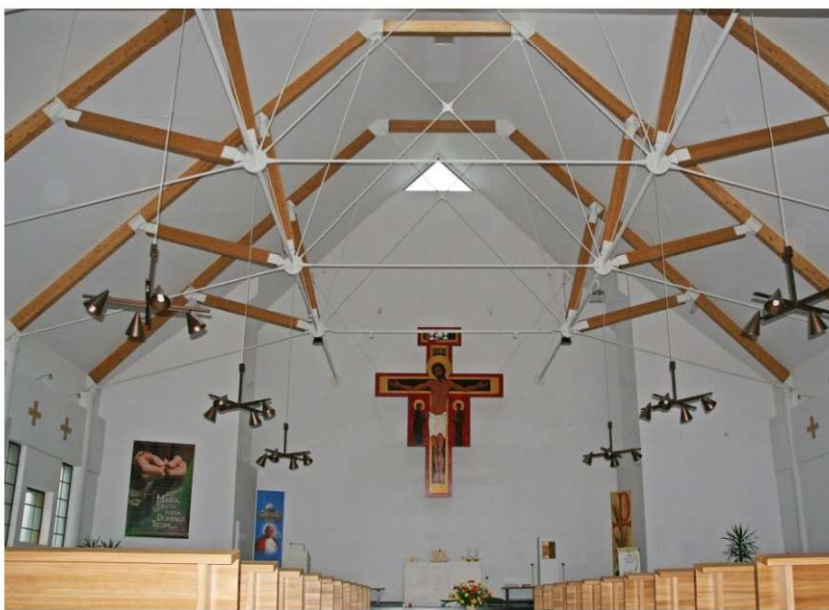
Fot.1.10 Kościół w Łodzi, rozpiętość 18,5 m (fot. E.I. Kotwica)
