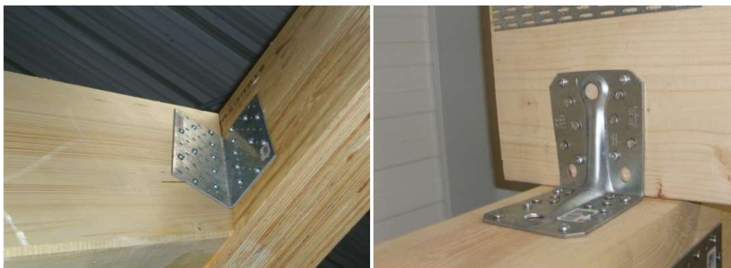
Fot. 7.22 TAK. Poprawnie wykonane połączenia z wykorzystaniem kątowników i projektowo dobranej ilości łączników. (fot. T. Szczesiak)
