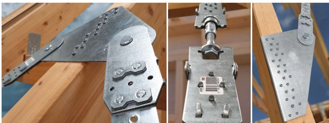
Fot. 7.20 TAK. Poprawnie wykonane detale stężeń systemowych z zastosowaniem taśmy perforowanej. Zastosowanie pokazanej na środkowym zdjęciu nakrętki napinającej pozwala na właściwe napięcie stężenia w przypadku zastosowania taśmy. (fot. T. Szczesiak)
