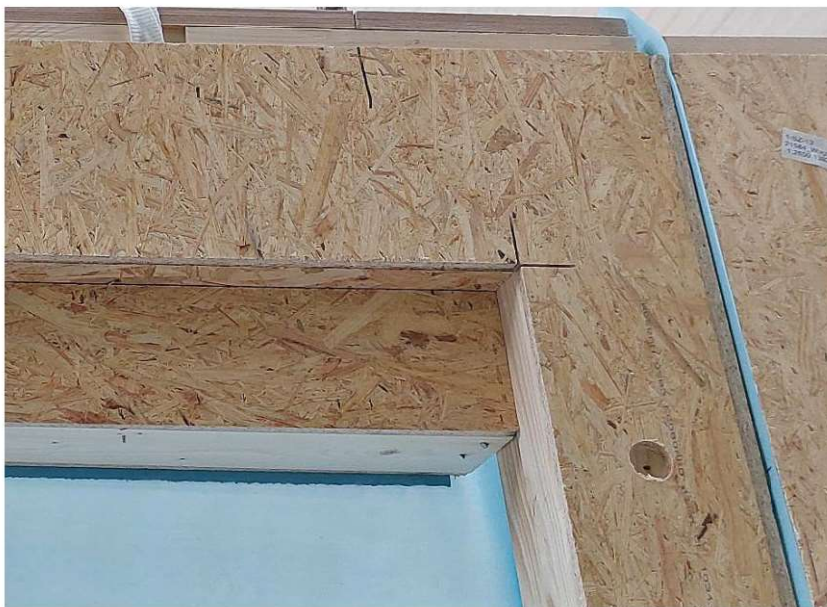
Fot. 5.4 Płyty w narożach powinny być wycinane z zachowaniem kształtu „L” (fot. Z archiwum EDG)
