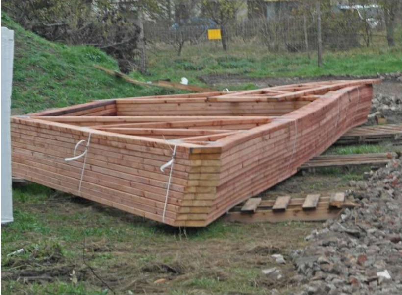
Fot. 7.7 Niepoprawny sposób składowania więzarów kratowych – widoczne odkształcenia spowodowane nierównością podparć oraz zbyt bliska odległość od ziemi. (fot. E.I. Kotwica)
