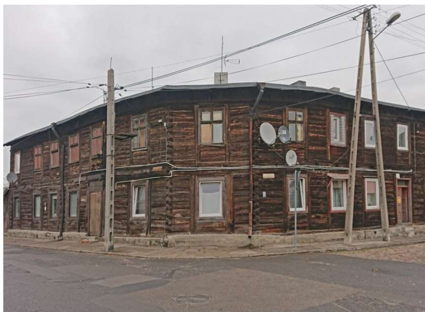
Fot. 1.1 Budynek mieszkalny w Zgierzu z połowy XIX w. (fot. E. I. Kotwica)
