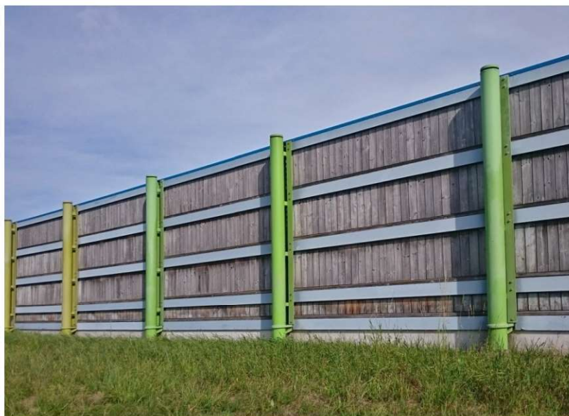
Fot.1.4. Ekrany akustyczne (fot. E. I. Kotwica)
