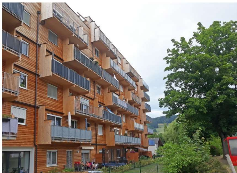
Fot.1.2. Budynek wielorodzinny w Leoben, w Austrii (fot. P. Sulik)
