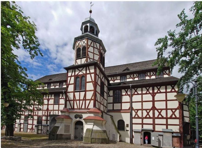
Fot.1.12. Świątynia Pokoju w Jaworze z 1655 r. (fot. E. I. Kotwica)
