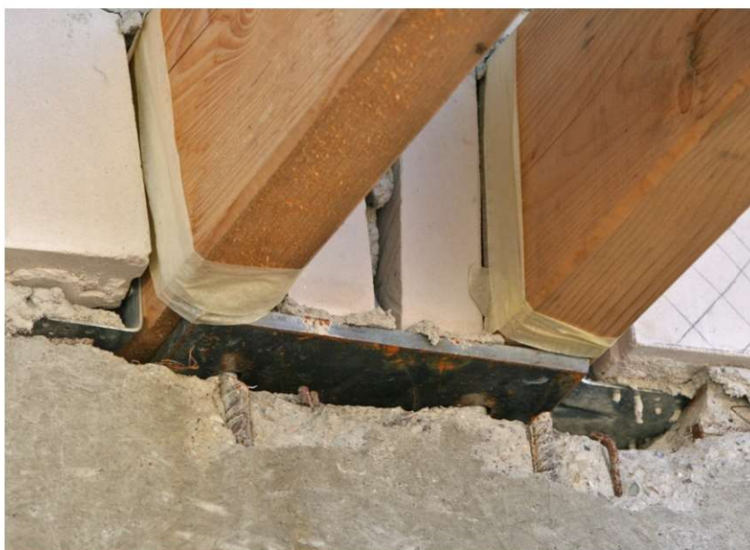
Fot. 7.12 Przypadkowe i niestaranne wykonanie połączenia na podporze. (fot. E. I. Kotwica)
