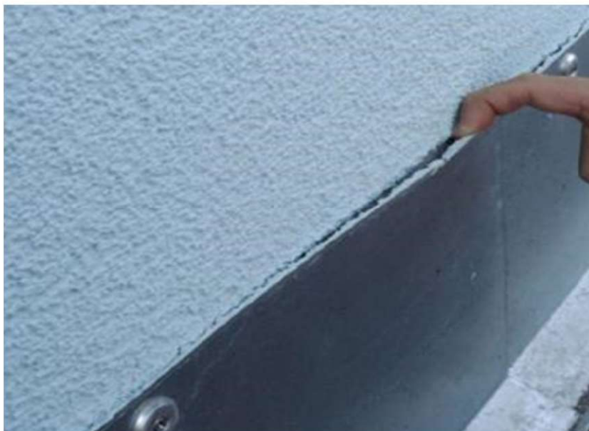
Fot.7.17 Niepoprawnie wykonana obróbka – z pominięciem systemowego profilu przejściowego. (fot. z archiwum Stowarzyszenia EDG)
