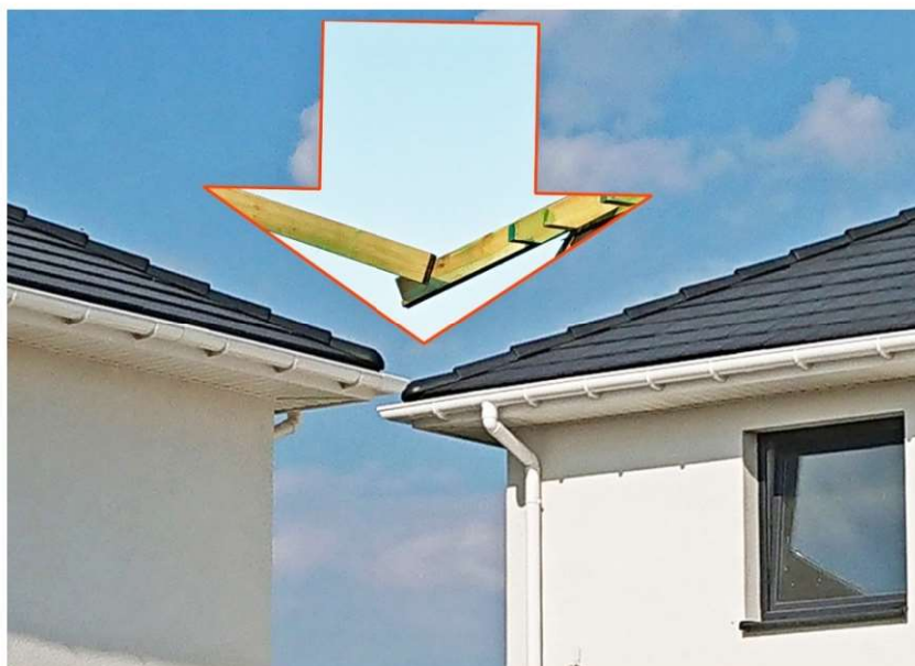
Fot. 7.1 Domy jednorodzinne na jednej działce. Odległość okapów rzędu kilkudziesięciu centymetrów (fot. E.I. Kotwica)
