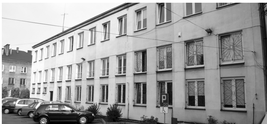
Szanse na termomodernizację ma m.in. budynek Ośrodka Pomocy Społecznej.
