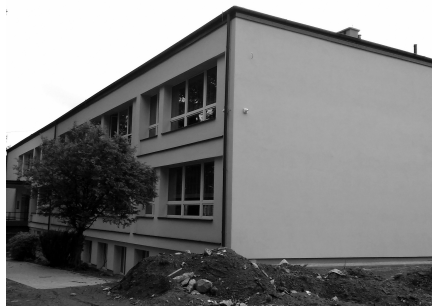
SP 2 ma już nową elewację.
