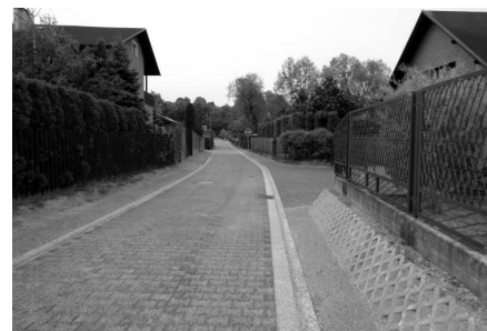
Na ul. Chrobrego ułożono nawierzchnię z kostki brukowej.
