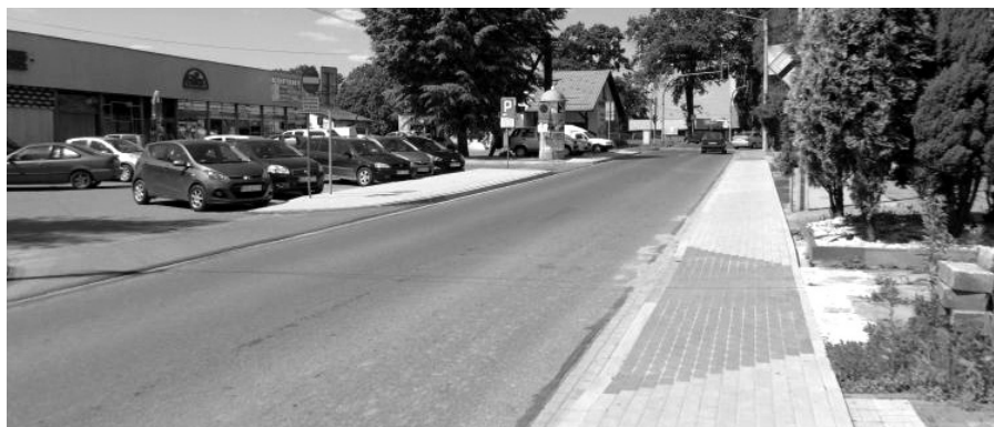
Chodnik powstanie też na odcinku za przejazdem kolejowym do ul. Ogrodowej.
