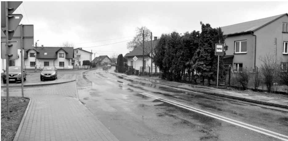
Przebudowa ul. Wypoczynkowej w Zasolu ma potrwać dwa miesiące.
