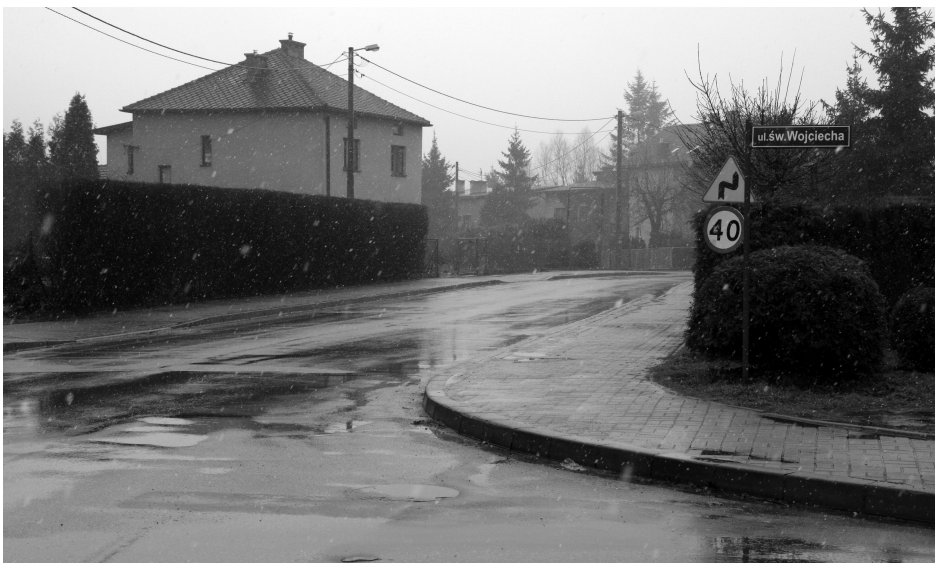
Przebudowa ul. Piastowskiej obejmie odcinek od skrzyżowania z ul. św. Wojciecha do skrzyżowania z ul. Ofiar Oświęcimia (przy sklepie Netto).
