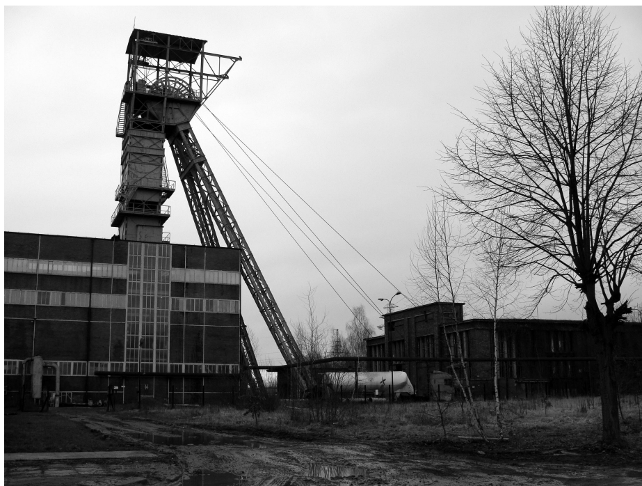
KWK „Brzeszcze Wschód” odpowiada m.in. za likwidację majątku po dawnym Ruchu II w Jawiszowicach.
